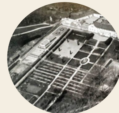
Figur 7.15.8 Flyfoto etter forenklingen i 1925
