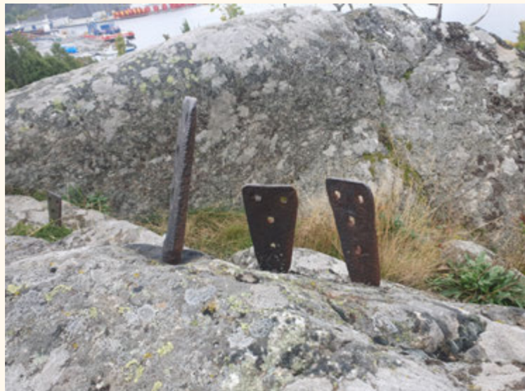
Figur 102: Eksempel på godt bevarte bolter
